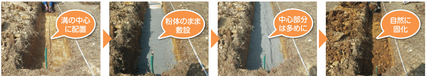
①溝を掘削し接地線を敷設
